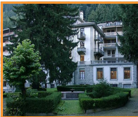
Centro di Formazione Professionale, sede del corso.
